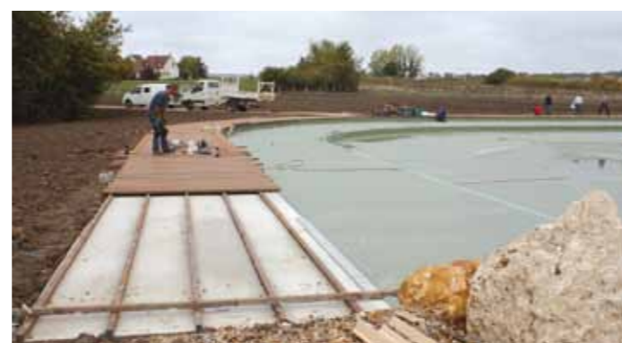
Septembre 2009 : mise en place du platelage en périphérie du bassin de baignade.
