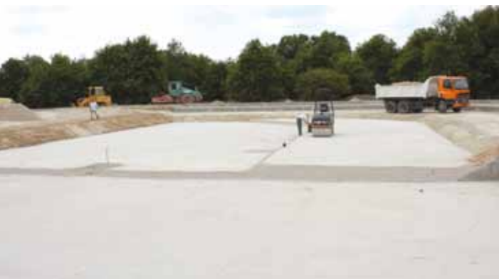
Juin 2009 : terrassement et mise en forme de la baignade.
