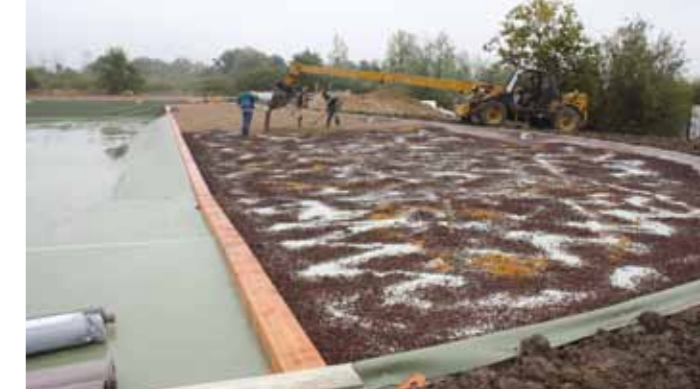
Octobre 2009 : installation de la pouzzolane qui servira de support à la végétation aquatique sur la zone de régénération en bordure de la baignade.
