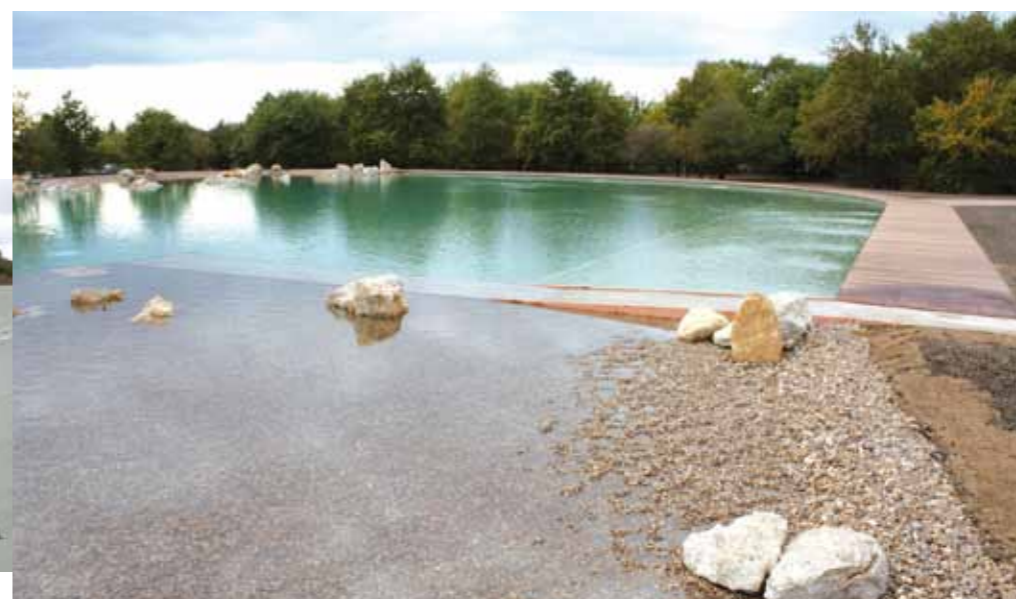
Octobre 2009 : vue d'ensemble de la baignade remplie d'eau en provenance du forage de la pisciculture voisine.
