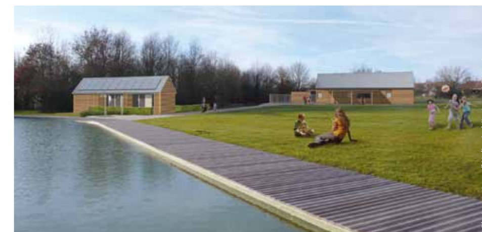
Perspective de l'ensemble du site : à gauche, les sanitaires avec capteurs solaires pour les douches, à droite, le bâtiment d'accueil.
