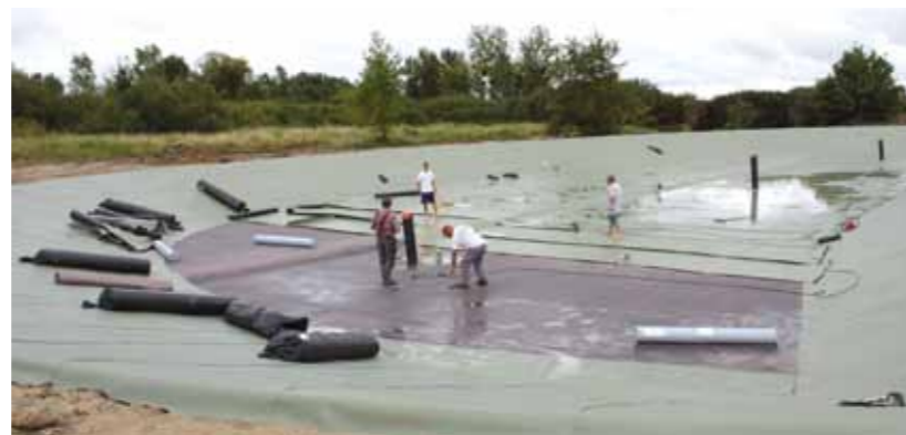
Juillet 2009 : pose du feutre de protection au fond du bassin de filtration et installation de la membrane étanche.
